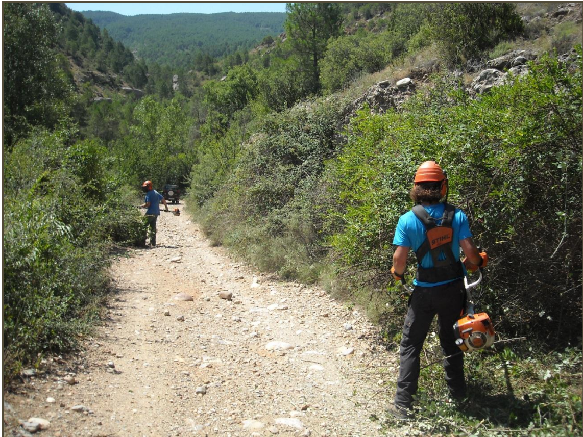
Treballs de neteja i arranjament de la pista de Sossís a la presa de Sossís, 27 de juliol.
